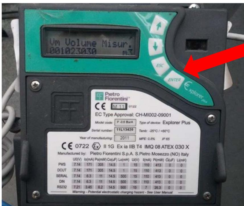
Il Convertitore di Volume gas è normalmente spento e il display non visualizza dati. Premere il tasto **ENTER** e visualizzare i dati **Vb** e **Vm** spostandosi con le frecce di scorrimento.
